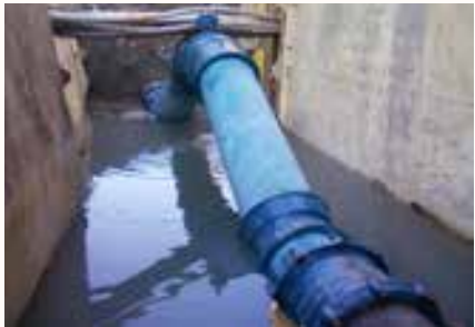
← Remplacement d'une conduite percée
