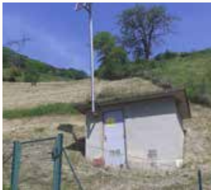
← Captage Arthaud à Seyssins
