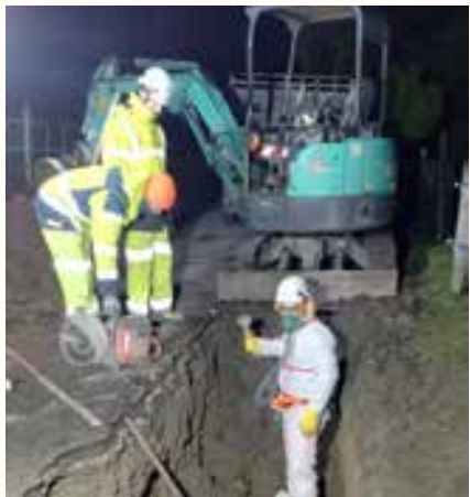
← Chantier nocturne à Muriannette en 2022
