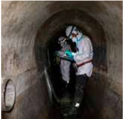
← Réseau unitaire visitable – Grenoble
